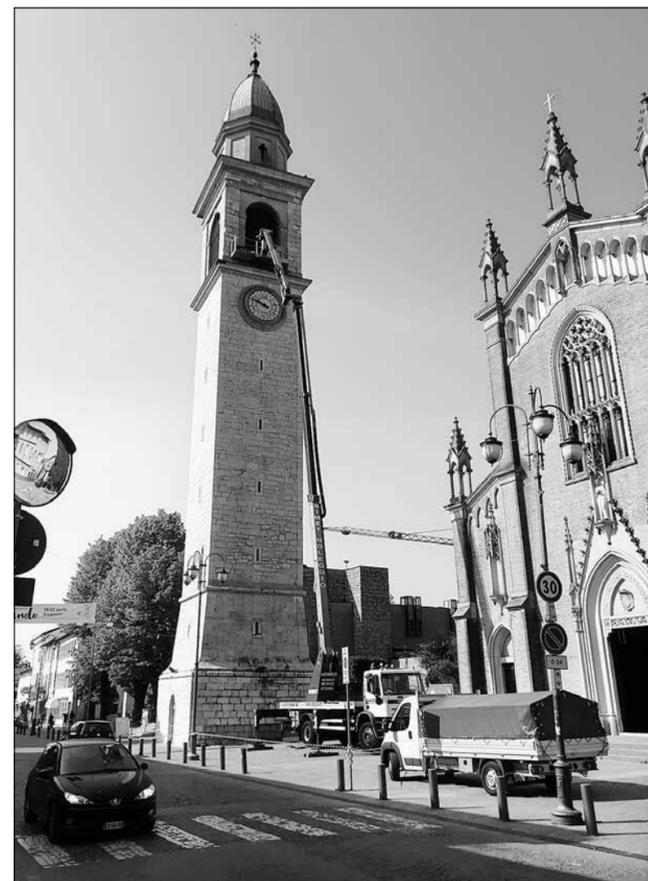
*Le reti anti-intrusione (per i volatili) del campanile, martedì 24 aprile sono state sostituite da reti in acciaio per necessità di sicurezza: ecco la grande gru usata per l'impegnativo lavoro.*
