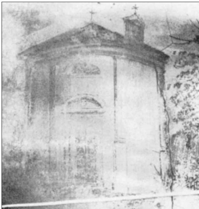
La Chiesa di Paradiso in un affresco di Rocco Pittacco (1850) che si trova nella Casa Canonica di Talmassons (particolare).
